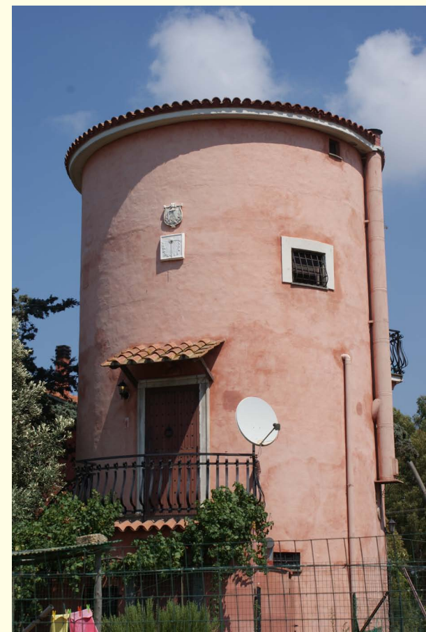
INGRESSO AL SILOSO RISTRUTTURATO
